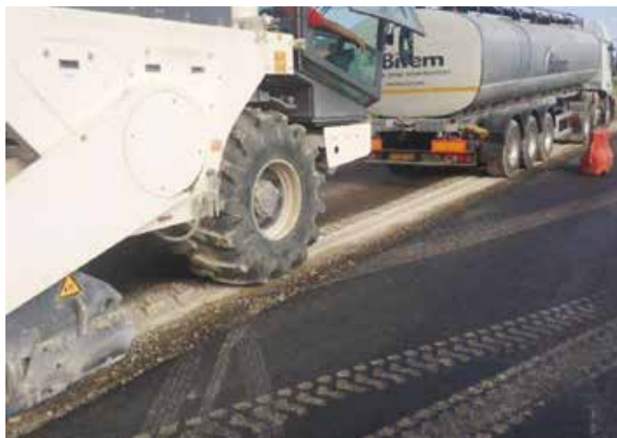
7. La rigenerazione a freddo in situ dello strato di base
