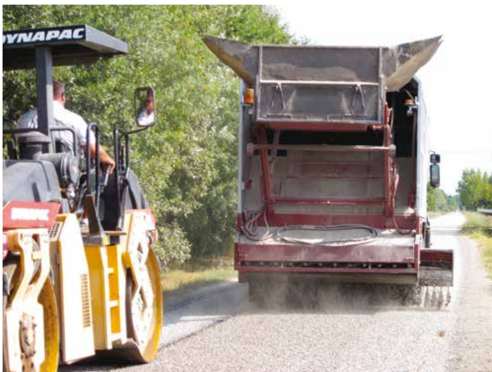
4. Un esempio di depolverizzazione di strada "bianca"
