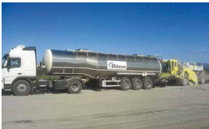
8. Il sotto-base in MCAD-Misto Cementato ad Alta Duttilità
